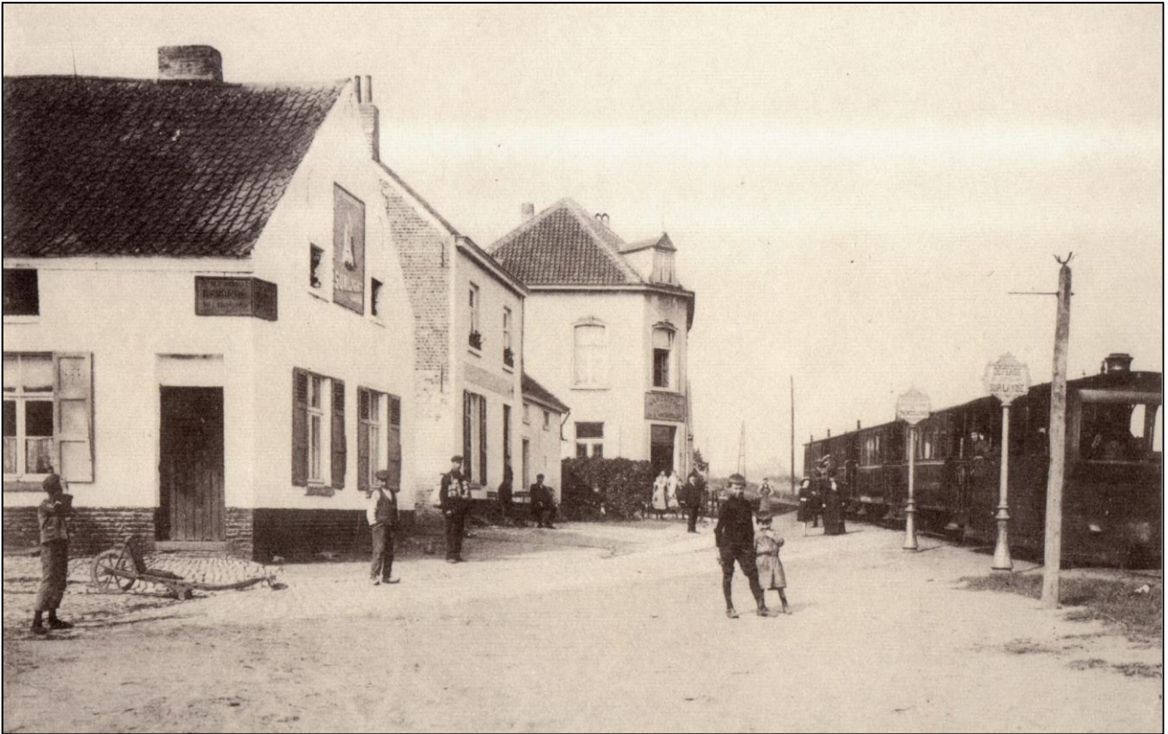
De tramhalte aan de hoek van de Boechtstraat en de Nieuwelaan.
